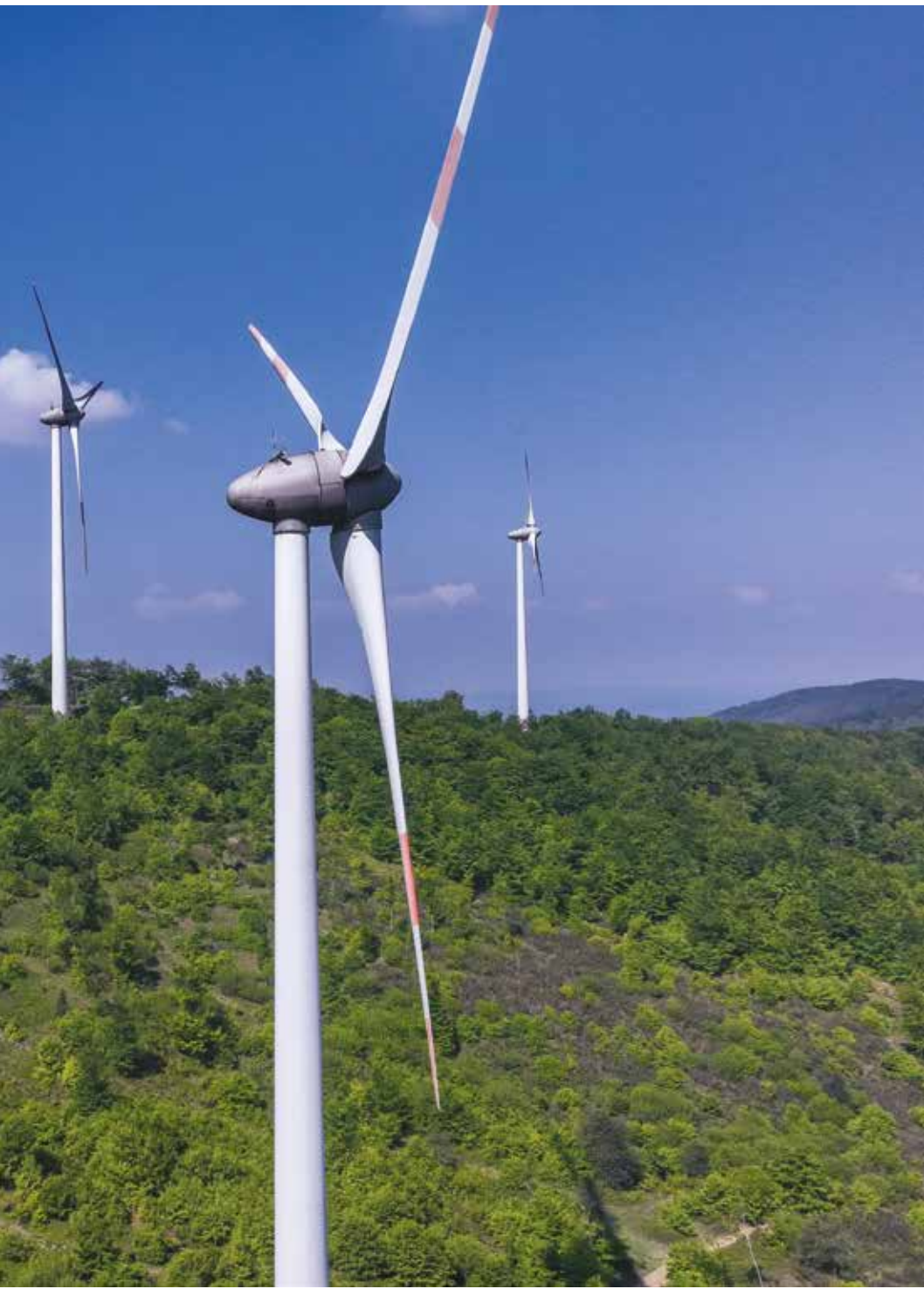
PARCO EOLICO NASO DI GATTO, COMUNI DI SAVONA, CAIRO MONTENOTTE E ALBISOLA (SAVONA) © MARCO RIMONDI
