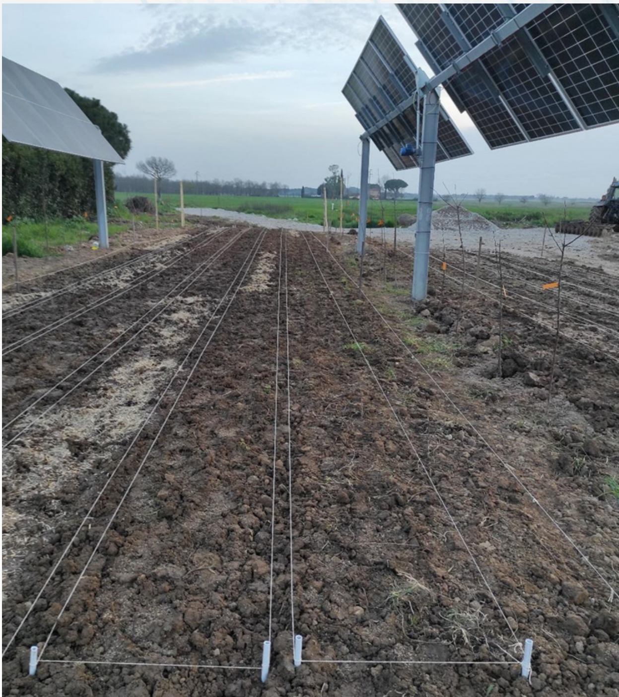
Figura 2. Impianto Agroforestale-Fotovoltaico Demo: allestimento sperimentazione agronomica (azienda Le Rogaie, Grosseto).
