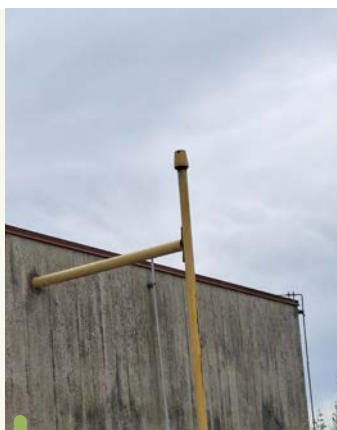
Venting del REMI di Monte Urano (FM)
