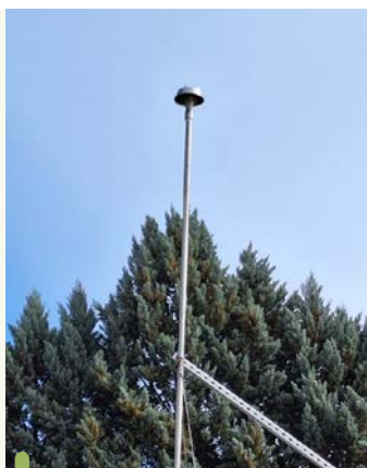
Tubo di sfiato nella cameretta di misura Eni a Grumento Nova (PZ)
