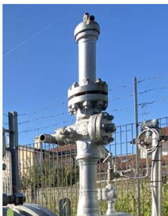
Flange nella stazione di valvola di Adria (RO) di Snam
