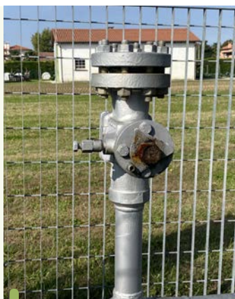
Flangia nella stazione di valvola di Mirano (VE) di Snam
