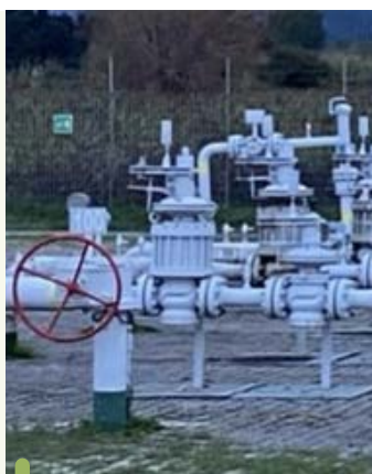
Gruppo di flange e valvole nel REMI a Lamezia
