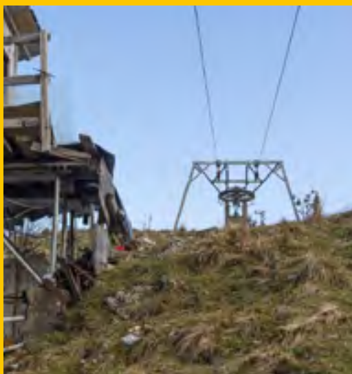
Impianti Loc. Monte San Primo
