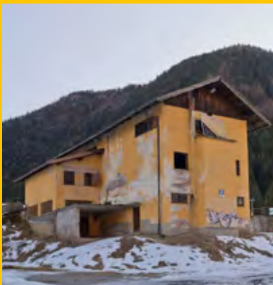
Foto Impianti Loc. Monte Epolo
